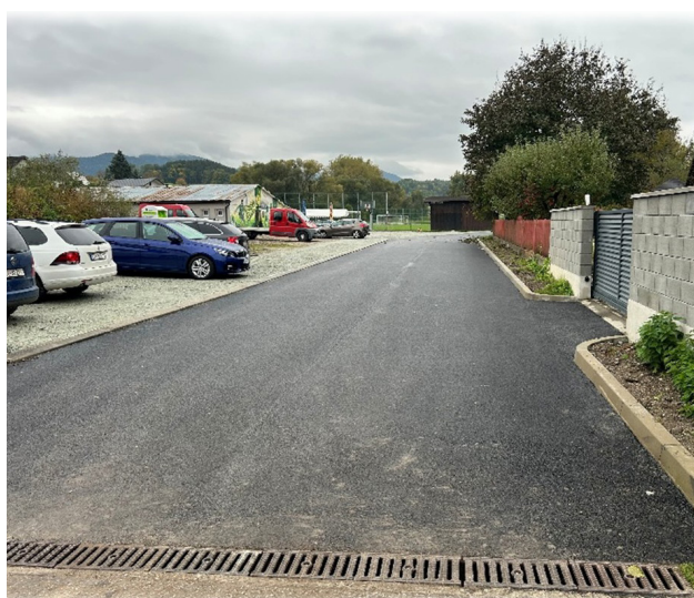
Súvislá oprava asfaltových vrstiev v MČ Trnové
