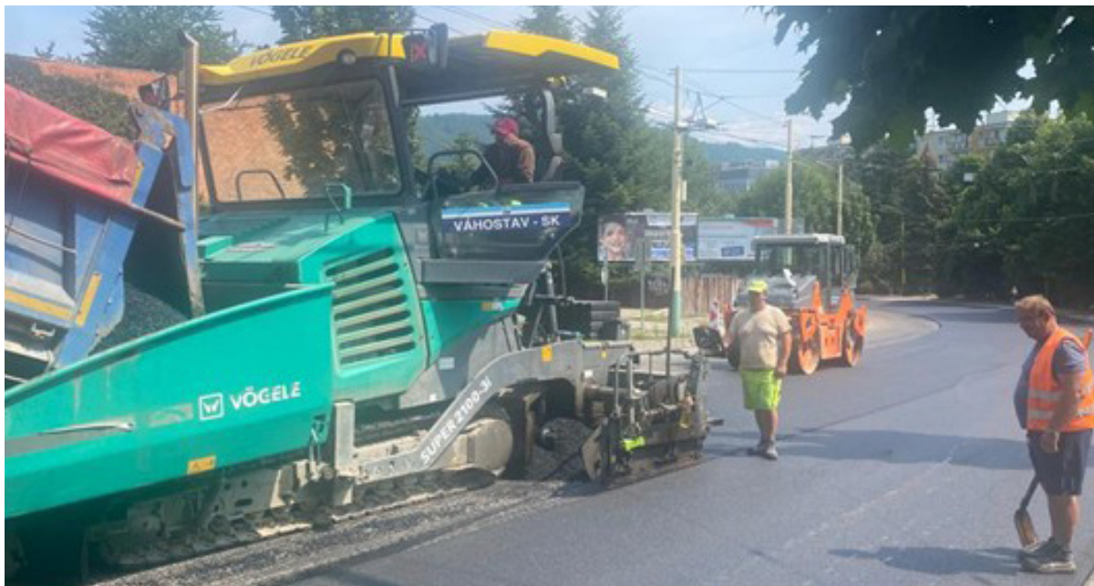
Priebeh veľkoplošnej opravy krytu vozovky na Veľkej Okružnej
