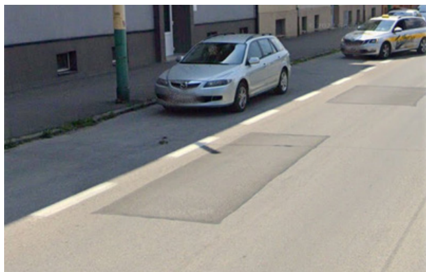
Opravené výtlky na ul. 1.mája v Žiline
