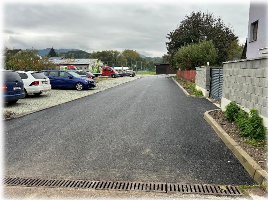
Obrázok 3 Súvislá oprava asfaltových vrstiev v MČ Trnové
