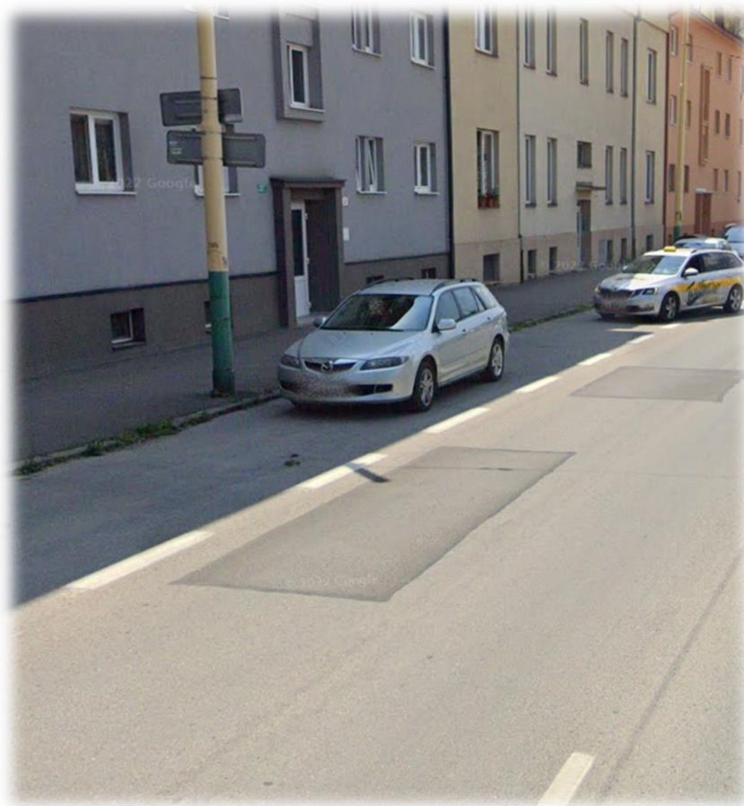
Obrázok 1 Opravené výtlky na ul. 1.mája v Žiline
