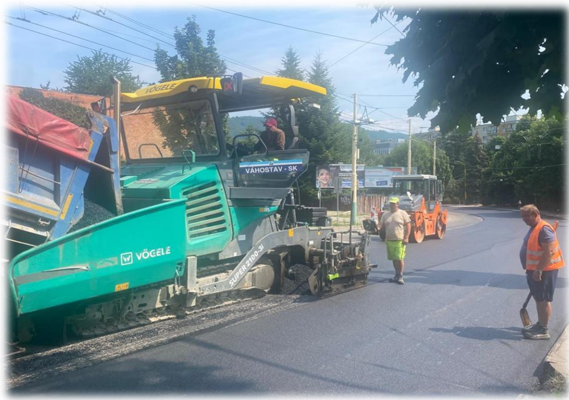
Obrázok 4 Priebeh veľkoprošnej opravy krytu vozovky na Veľkej Okružnej
