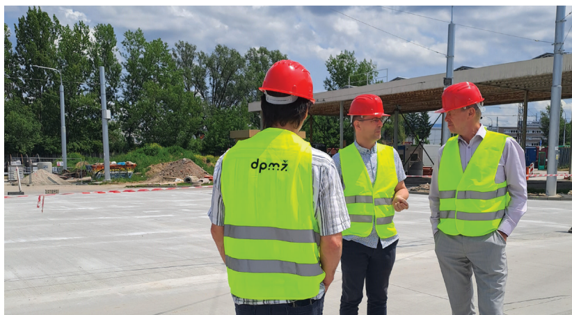
Obhliadka rekonštrukcie depa DPMŽ
