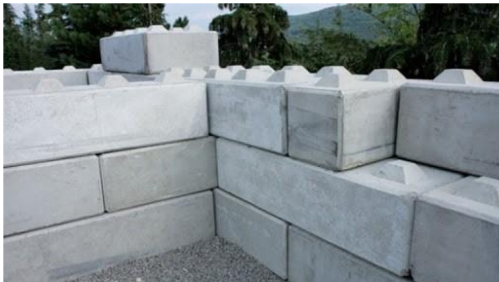
Príklad ohraničenia vytvoreného z betónových blokov
