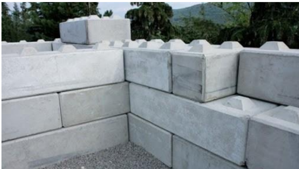
Príklad ohraničenia vytvoreného z betónových blokov
