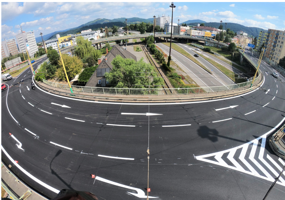
Rekonštrukcia povrchu vozovky na Rondli urobili za víkend.
