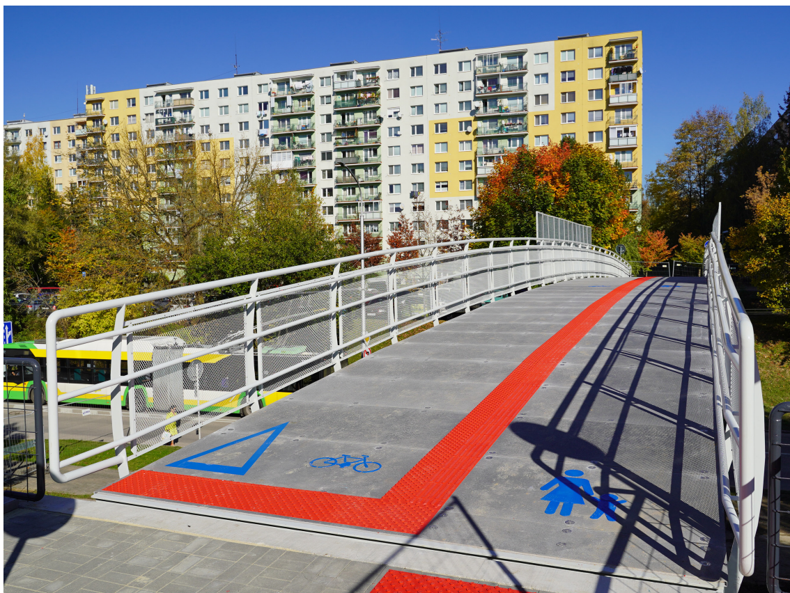
Lávka na Vlčincoch po rekonštrukcii.
