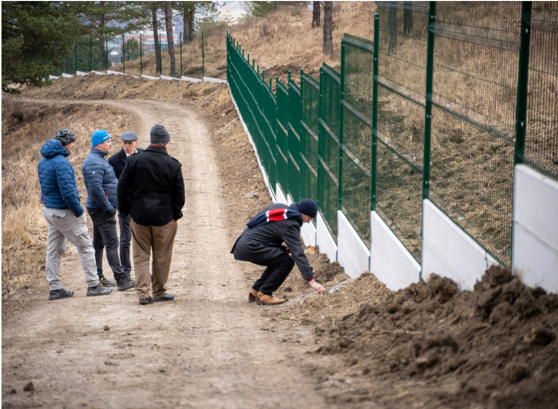
Obhliadka nového oplotenia na Novom cintoríne.
