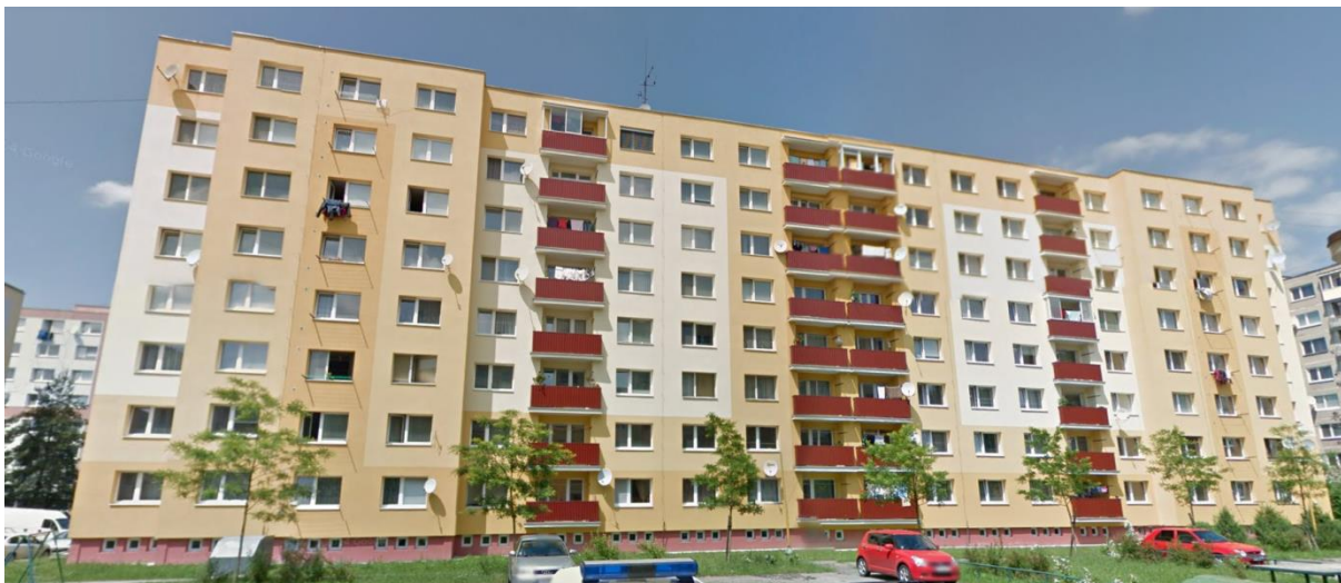
Obr. 79 Riešený bytový dom ul. Polomská 1781
