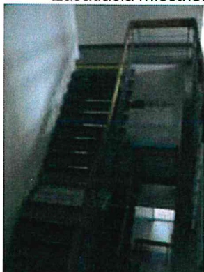
Schodisko v časti A
