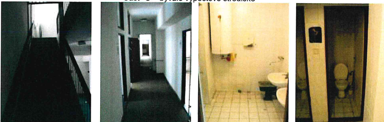
Časť C – schodisko chodba a soc. priestory
