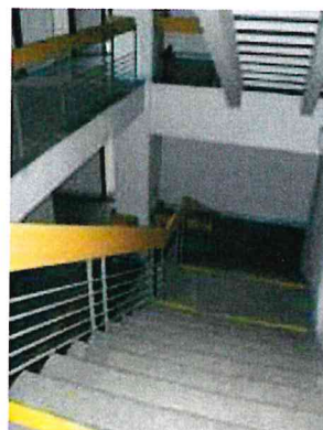
Schodisko v časti A
