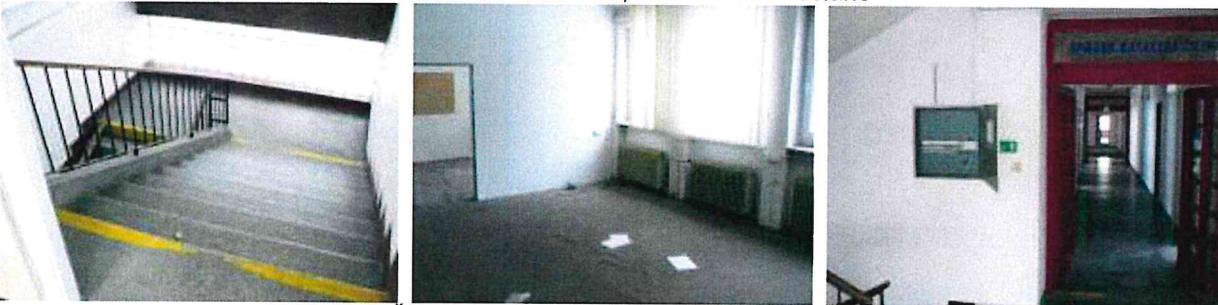
Časť B – schodisko, chodba a kancelárie
