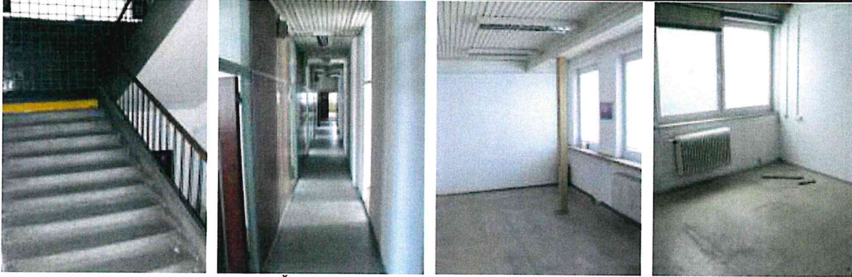
Časť B – schodisko, chodba a kancelárie
