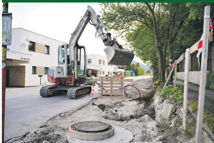
Výstavba nového chodníka v Budatíne.
