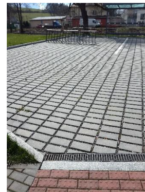
Dlažba na širokú sparú, ktorá umožňuje infiltráciu vôd do podlažia (Bílovec, ČR)
