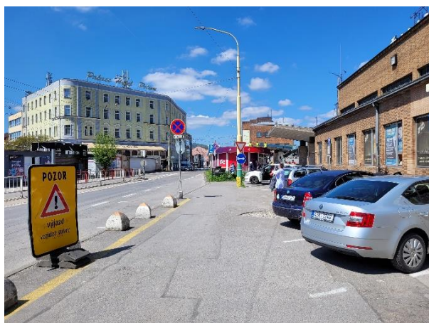
Železničná stanica Žilina bez stromov a zelene
