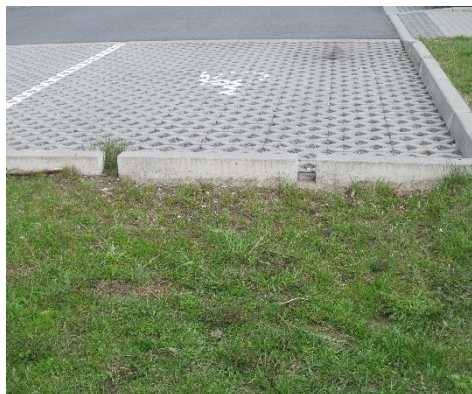
Odvod zrážkovej vody cez obrubníky do zelene (Bruntál, ČR)
