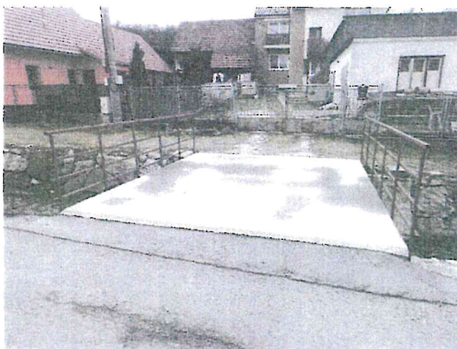
Mostík na p. č. 1189/2 a 1194/3 - celkový pohľad J z prístupovej - miestnej komunikácie - priamo RD č. s. 223
