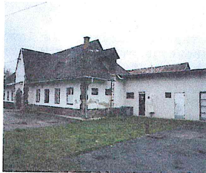
Budova súp. č. 802 - jedáleň - celkový pohľad JZ z prístupovej cesty, vpravo sklad so soc. zariad a kotolňou
