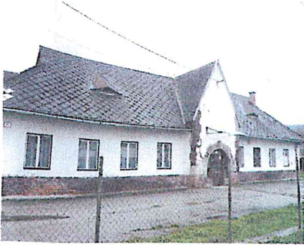
Budova súp. č. 802 - jedáleň - celkový pohľad SV z prístupovej cesty
