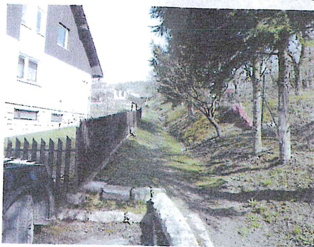
Prvý úsek trasy vedení od parc.č. KN - C 723/148 smerom po trase prac. č KN - C 961/1 - pohľad V
