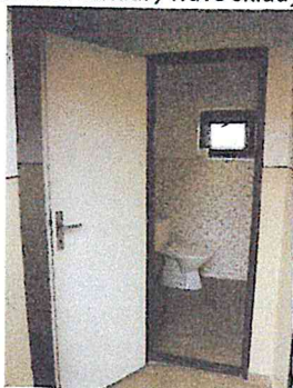
Soc. zariadenie v budove skladu .....
