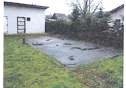
Veľkorozmerová kanal. žumpa vo dvore areálu
