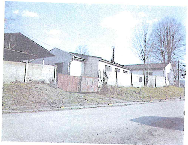
Pohľad JV od hl. vstupu do areálu SSC, a..s., priamo v oplotení kovové vráta prístupu na pozemok, z časti viditeľným ocelovým prístreškom
