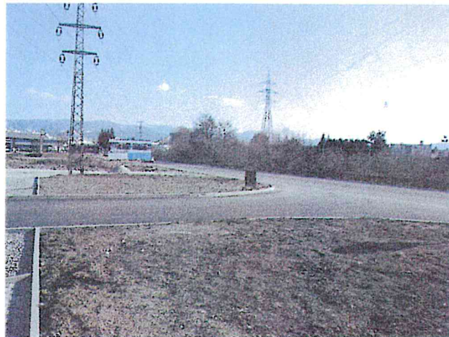
Detailný pohľad JV na priestor situovania hodnotených parciel - vybudovaný prejazd z parkoviska pred objektom auto umyvárne k miestnej komunikácii - Bánovskej ceste ( vpravo )
