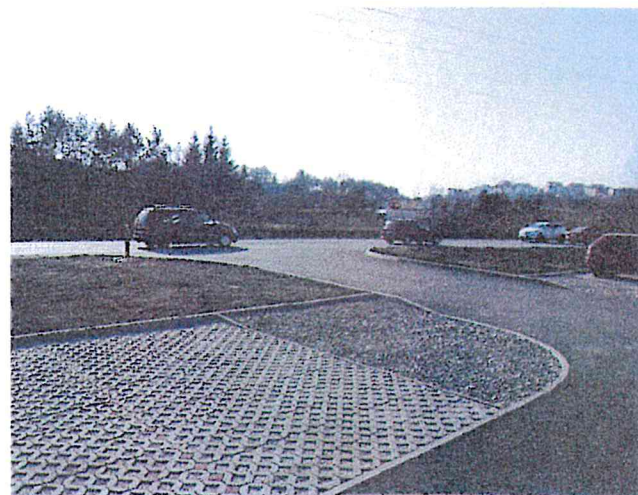
Detailný pohľad Z na priestor situovania hodnotených parciel - vybudovaný prejazd z parkoviska pred objektom auto umyvárne k miestnej komunikácii - Bánovskej ceste ( vľavo )
