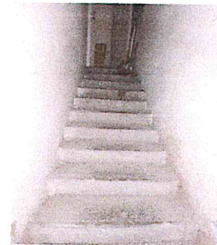
Spoločné priestory – schodište do I. PP
