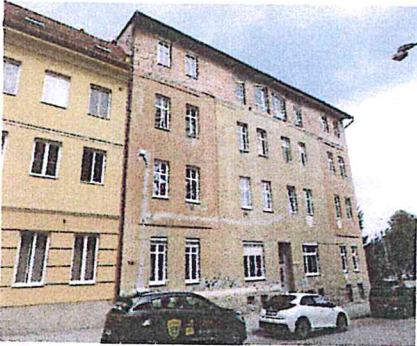
Bytový dom č. s. 1337 – celkový pohľad Z z Predmestskej ul.
