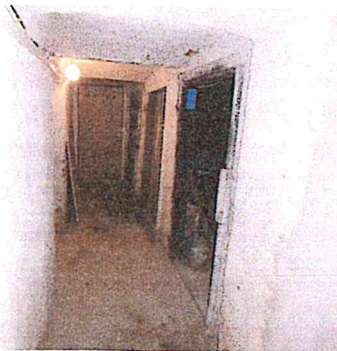
Spoločné priestory – komunikačná chodba v I. PP, vpravo vstup do Priestoru č. 1
