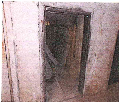
Priestor č. 1 – pohľad na vstupné dvere z komunikačnej chodby
