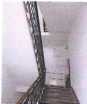
Spoločné priestory – hlavné schodište v dome
