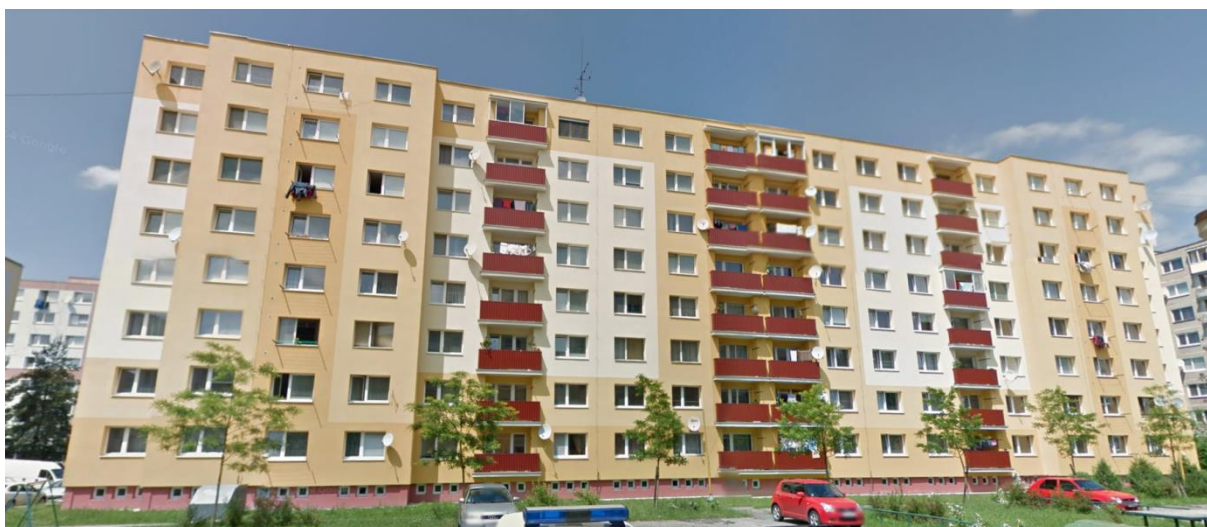
Obr. 79 Riešený bytový dom ul. Polomská 1781
