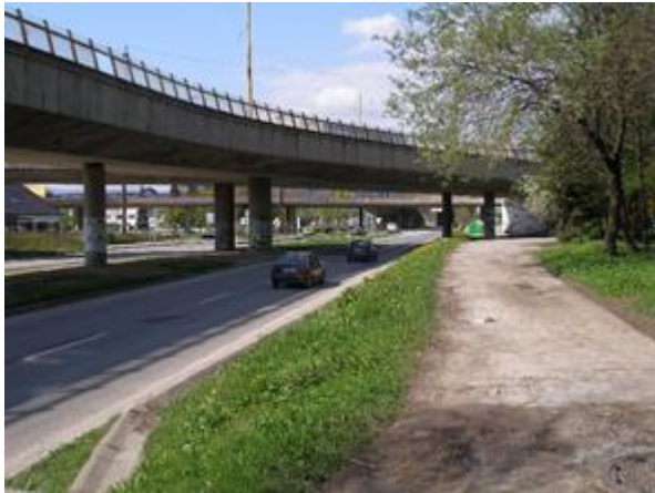
Foto: Chýbajúca izolačná zeleň.
