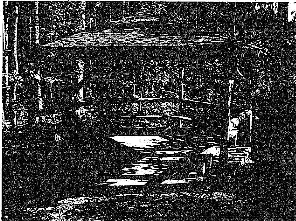
Foto 2: Vyčistenie lesoparku Chrást v blízkosti areálu detského ihriska a výstavba altánku pre verejnosť
